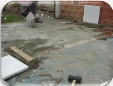
3. Após a fixação das taliscas esticar duas linhas (no sentido do alinhamento) separadas uma da outra pela da largura da placa, para servir de mestra, tanto do nivelamento quanto do alinhamento, no momento do assentamento.
