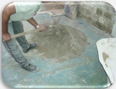
2. Sem adicionar água efetue a mistura dos dois materiais até a homogeneização total da mistura.
